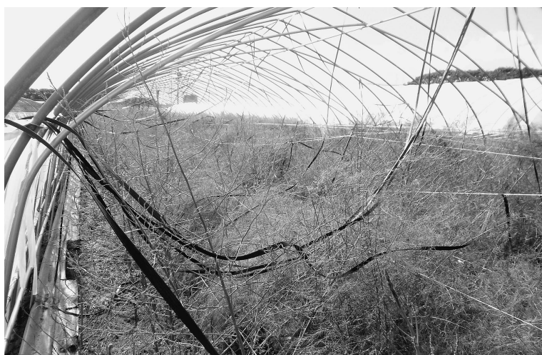
←台風で飛ばされたビニールハウス
